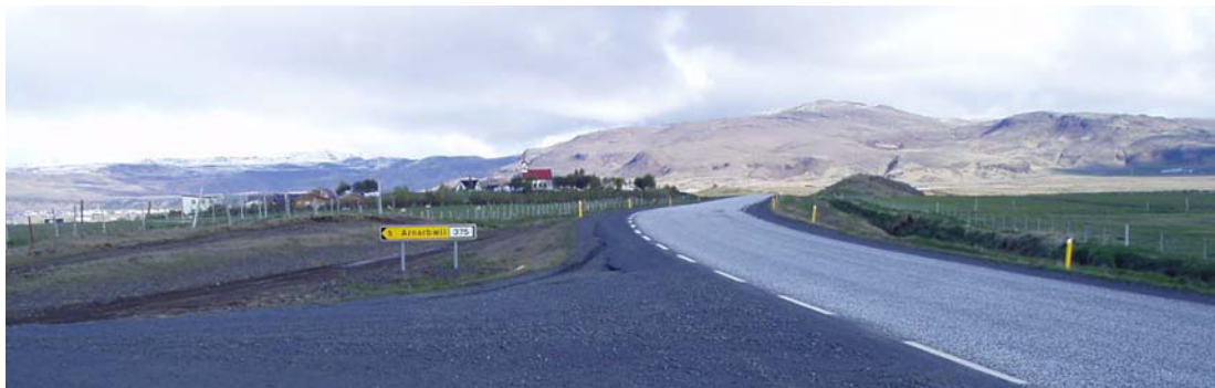
Mynd 3-1 Horft frá Arnarbælisvegi (375) vestur að Kotstrandarkirkju. Suðurlandsvegur verður færður til norðurs og vegurinn hér nýttur sem innansveitarvegur (mynd Efla).
