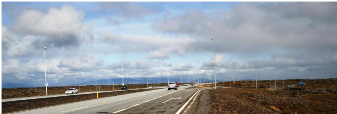
Mynd 4-24 Mislægu vegamótin verða lítt áberandi. Reykjanesbraut við Hvassahraun.
